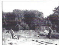
1970 begannen ehrenamtliche Helfer mit dem Aufbau der Schmiede
