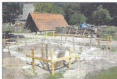
Das Fundament des Backhauses neben dem alten Backofen
