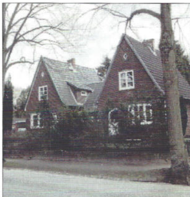
Eine kleine, durch ein Nebengebäude verbundene Hausgruppe an den „Schwarzen Wöörden“ mit liebevoll wieder hergestellten Sprossenfenstern und den schwarz gedeckten Steildächern. (Hi. 07)
