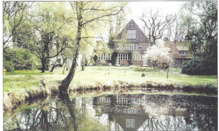
Langenwiesen 15, Das Bild vom Anwesen des Künstlerehepaars Emil Maetzel und Dorothea Maetzel-Johannsen zeigt deutlich die Symbiose von Haus und Garten. Die heute für die Werkstatt der Töpferei geschlossene Erdgeschosszone war ursprünglich eine offene Pfeilerloggia. Im Giebel deutet das hohe Fenster auf den dahinter befindlichen Atelierraum. (KvB 06)
