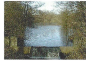
Abb. oben: Wandse: Auslauf Pulverhofteich: Staue dieser Art zerschneiden vollständig die Lebensräume der Gewässerorganismen.
