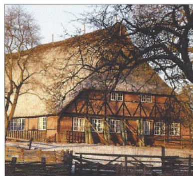
Das abgestützte Spiekerhus
