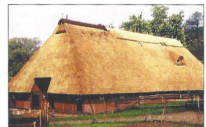
Durchfahrthaus (Wagnerhof) kurz vor seiner Vollendung
