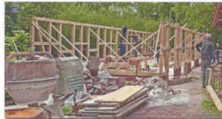
Mai 2014: Das Fachwerk wird gerichtet und...
