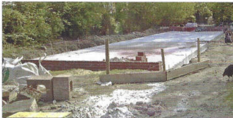
... die Fundamentplatte wird gegossen.
