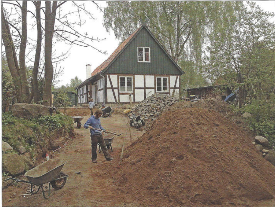
Der „Rückbau“ geht seiner Vollendung entgegen
