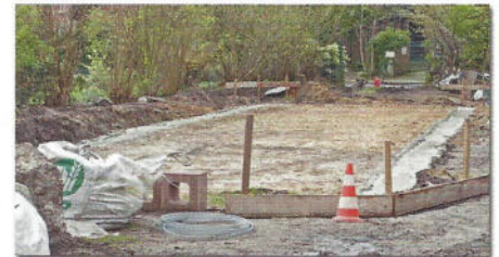
April 2014: Kies-Planung, Streifenfundament und...
