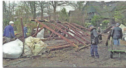
März 2014: Das alte Gebäude wird abgerissen
