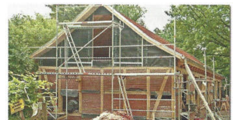
Juni 2014: Die wasserfeste Dachabschalung ist fertig
