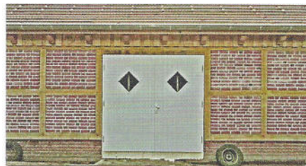
Juli 2014: Die Tore werden eingesetzt
