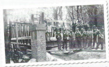
Bau der Brücke über der Eulenkrugstraße
