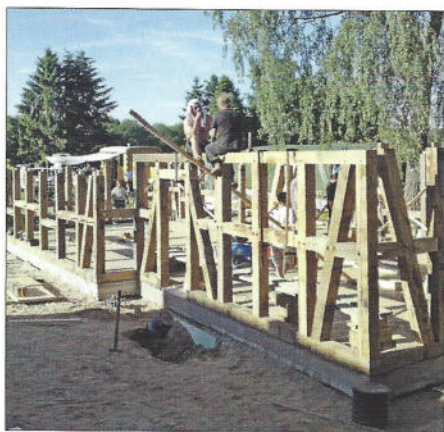
Das Fachwerk wird errichtet – im Hintergrund der Bauwagen
