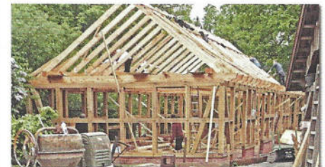
... auch der Dachstuhl
