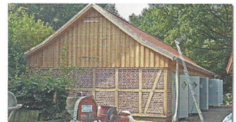
Ende Juli 2014: Das Dach ist dicht
