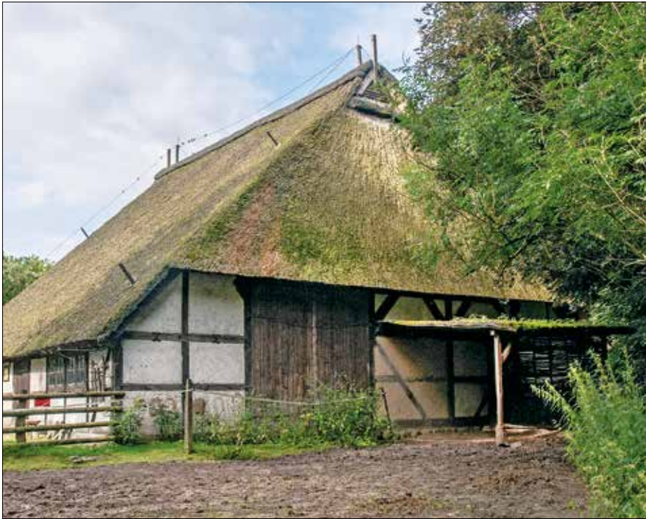
Die Durchfahrtscheune 2017: einige Gefache sind saniert, die Lehmoberflächen sind wie im Originalzustand nicht gekälkt. Die weißen Flächen warten noch auf die Sanierung
