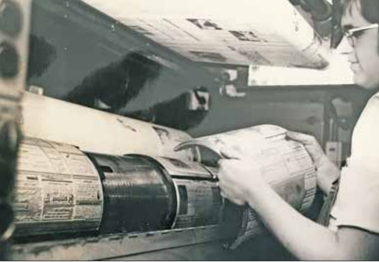
Montage einer Druckform auf einen Zylinder (Foto: Archiv der Bergedorfer Buchdruckerei)
