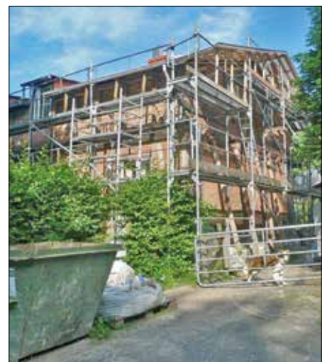
Juni 2017: Die Sanierung ist in vollem Gange (Foto: Leslie Leuzinger)
