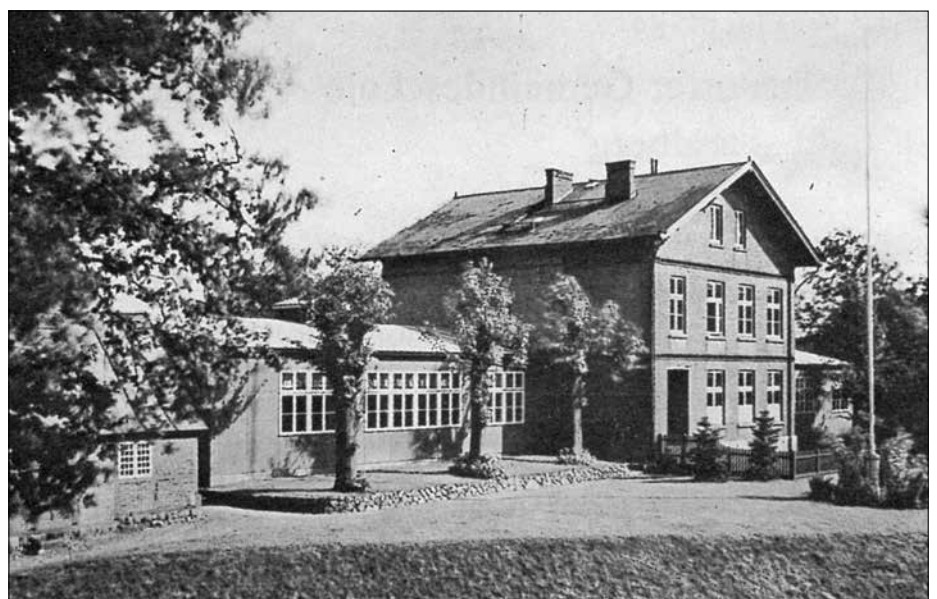
Gemeindeschule 2: Das Schulhaus mit den beiden Pavillons um 1940
