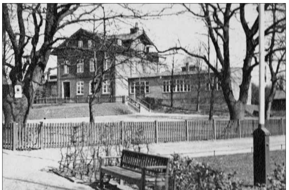
Das Schulhaus mit dem südlichen Pavillon und dem Schulhof
