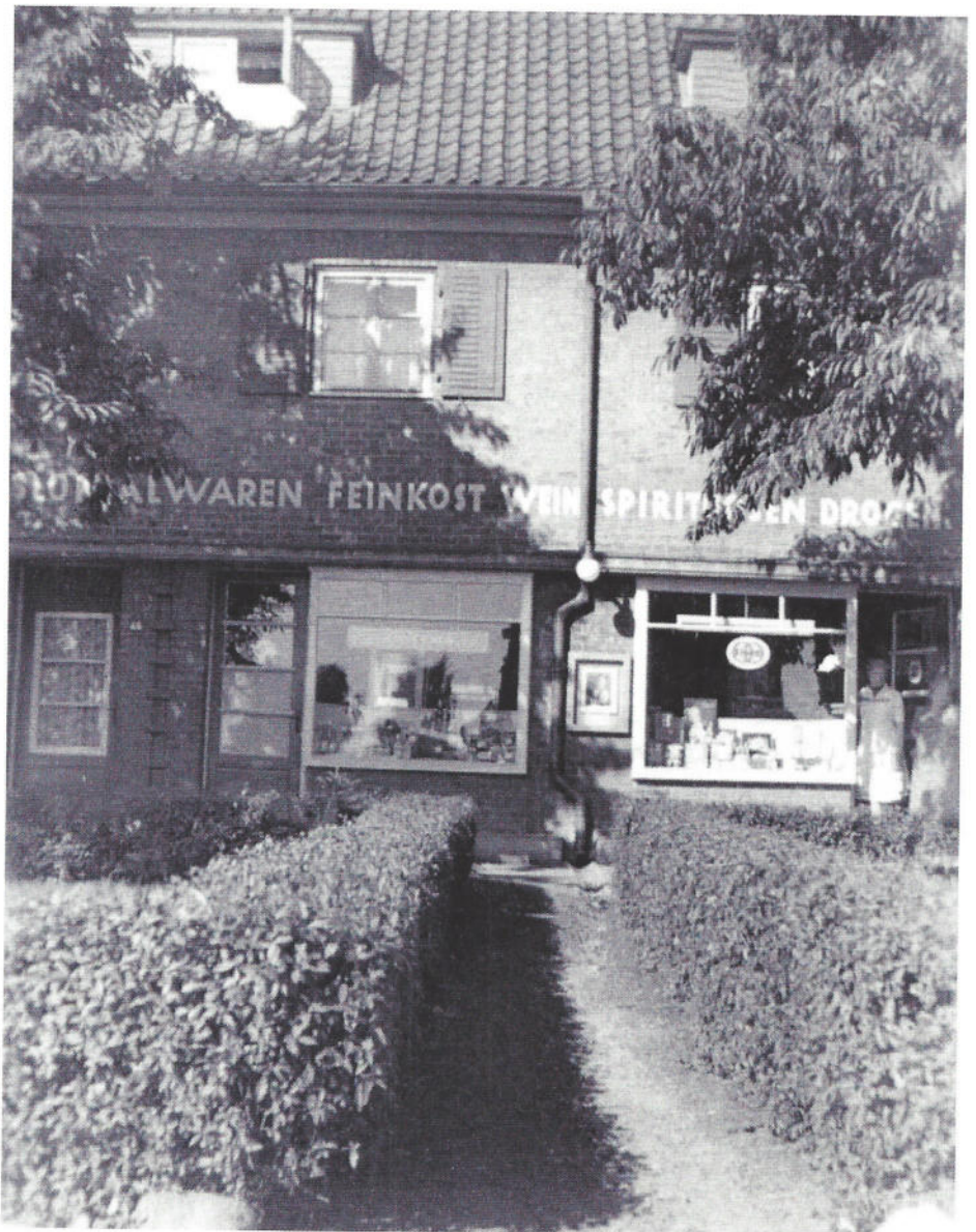
Teilansicht der Ladenzeile in der Siedlung Wensenbalken
