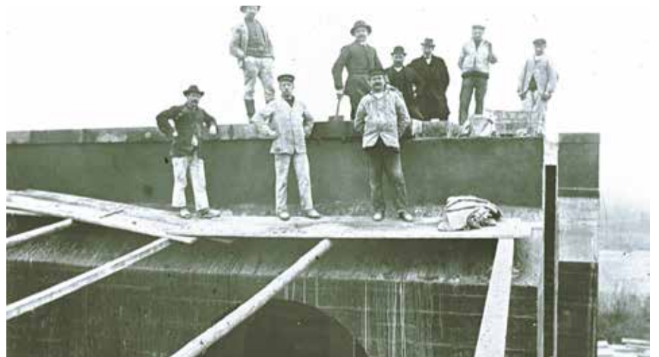
Bau des Fußgängertunnels an der Farmsener Landstraße im Volksdorfer Wald
