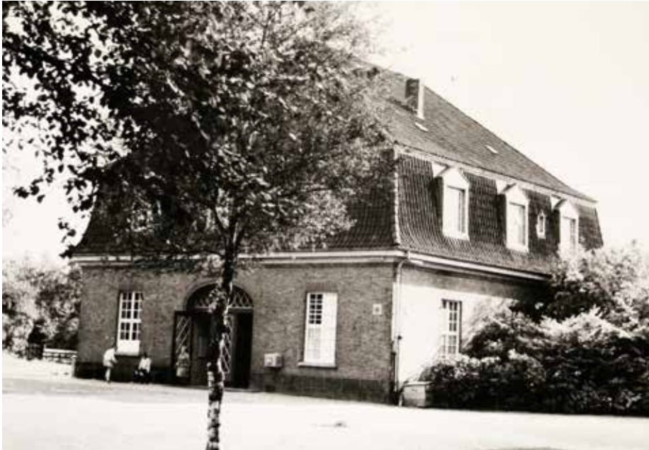
Bahnhof Buckhorn mit Betriebswohnungen im Obergeschoss
