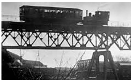
Belgische Dampflokomotive mit Hochbahnwagen auf der Brücke bei Barmbek
