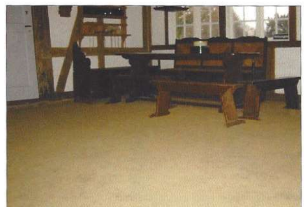
Abb. von oben nach unten: Das neue Backhaus, die Gefache sind mit Ziegeln ausgemauert, aber noch unverputzt Das neue Backhaus, fertig verputzt Wagnerhof: Lehmputz Spiekerhus: Stampflehmputz
