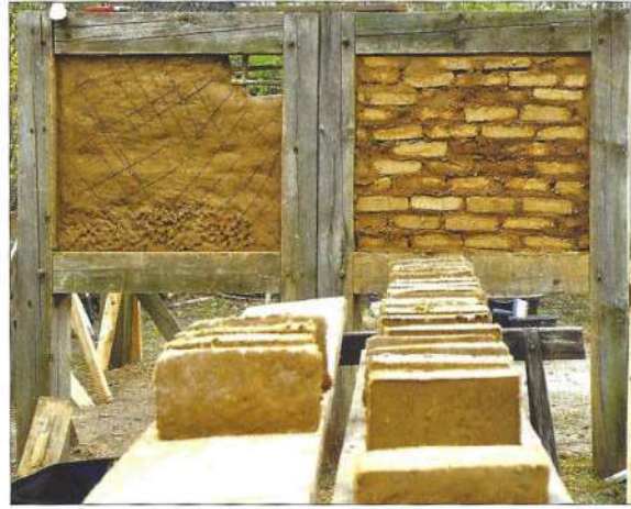
Abb. von oben nach unten: Lehmproben rechts daneben: Übungsfächer (links: Ausflechten, rechts: Ausmauern) Lehm zum Verputzen anrühren Verputzen eines Faches mit Feinputzlehm Verputzen eines Faches mit Edelputz
