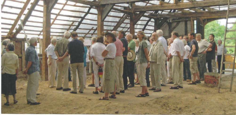
Stiftertreffen auf der Baustelle im Spiekerhus im Juli 2010
